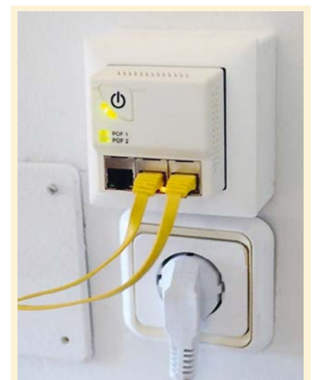
Figure 3. Dispositif de terminaison optique dans l'habitation pour fibre optique en plastique. Source : Telefónica.
