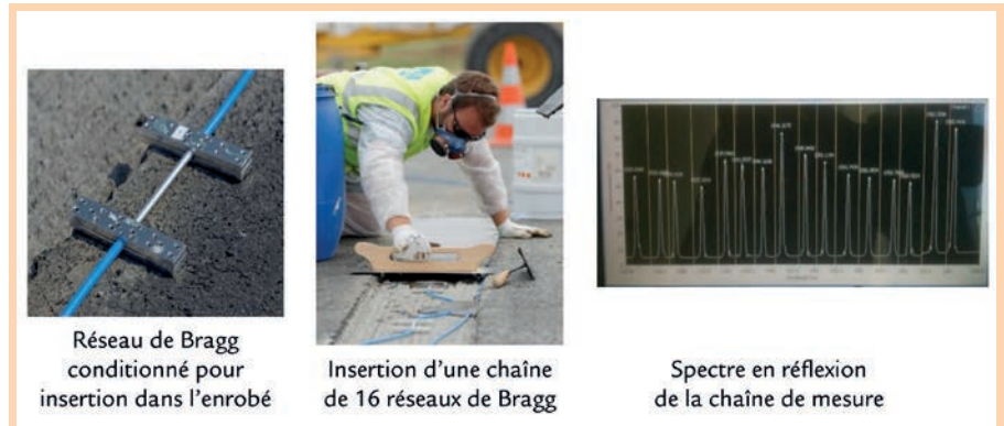
Figure 6. Conditionnement spécifique de réseau de Bragg pour insertion dans l'enrobé de tarmac.
