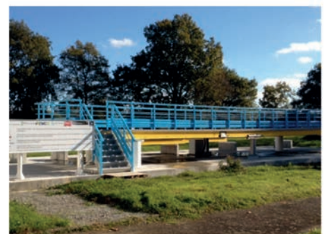
Passerelle équipée de réseaux de Bragg
