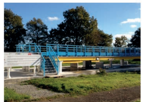
Passerelle équipée de réseaux de Bragg
