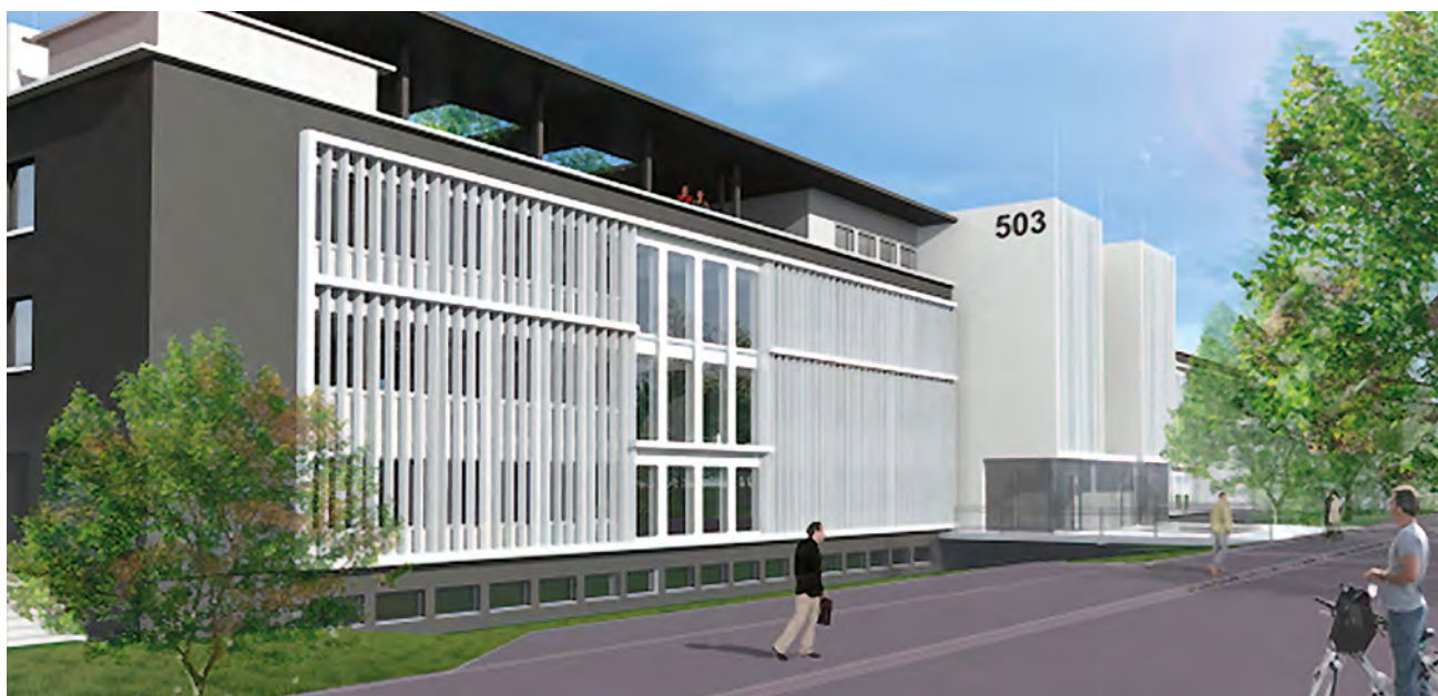
I Bâtiment 503 à Orsay entièrement rénové fin 2023
