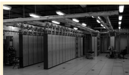
Figure 3. Terminaux sous-marins transatlantiques multi Tbit/s dans une station de Lannion (câble Apollo).
