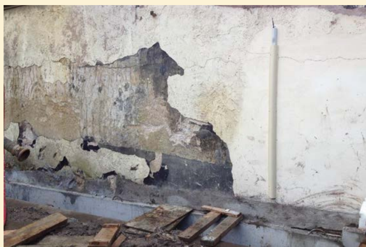
Figure 1. Surveillance de la stabilité de mitoyens – corde optique © OSMOS.
