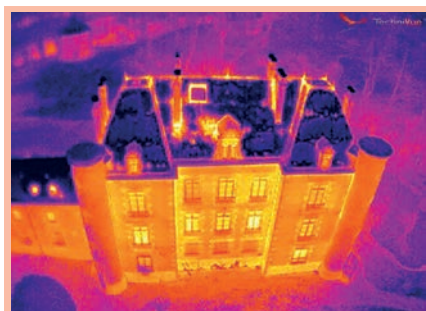
Figure 3. Une caméra infrarouge embarquée sur un drone permet de réaliser le diagnostic des déperditions thermiques d'habitations (image en bande LWIR, source : TechniVue).
